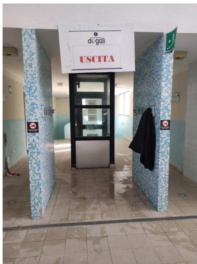
Immagine 3 –sbarco elevatore zona piscina
